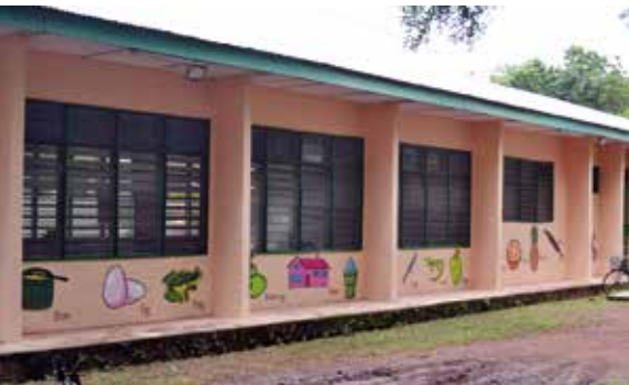
Teile des Gemeindehauses als Schulräume umgestaltet
